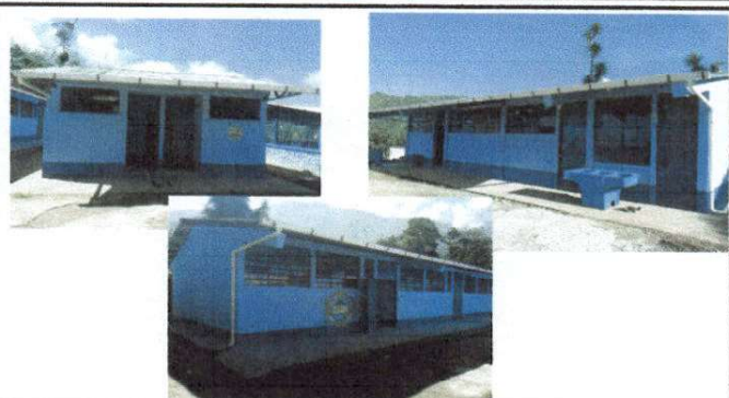
Foto No. 2 Canales y bajada de agua pluvial, pintura en muros interiores e exteriores
