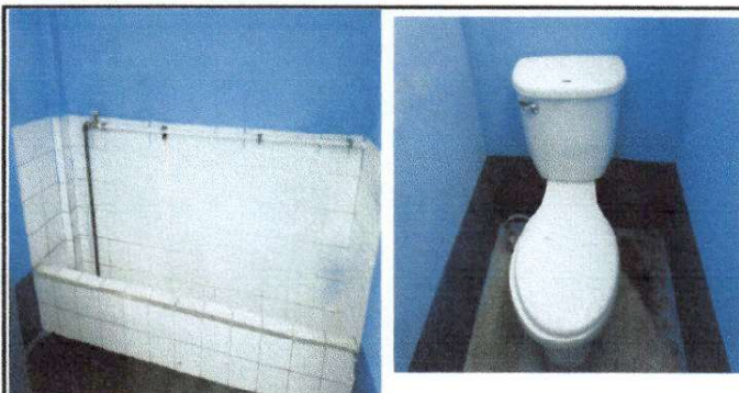
Foto No. 3 Cambio de inodoro y accesorios
