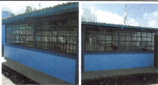
Foto No. 1 Sustitución de vidrios, y mantenimiento de balcones
