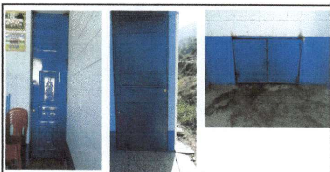
Foto No. 6 Sustitución de puerta de metal para gabinete, sustitución de puerta de metal, sustitución de chapa sobrepuesta Yalle
