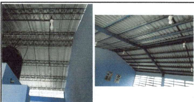
Foto 5: Mejoramiento del sistema eléctrico
