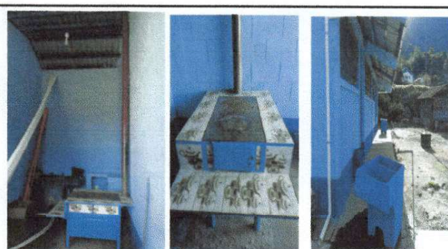
Foto No. 4. Sustitución de estufa rural completa, chimenea, plancha de metal, sustitución de pila de cemento de uno y dos lavaderos
